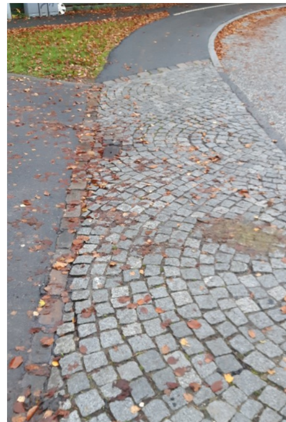
Overkørsel i chaussesten på Lyngvej ved Vibevej
