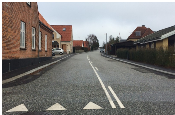
Nyvangsvej - Fortove i asfalt og in-situstøbte kantsten
