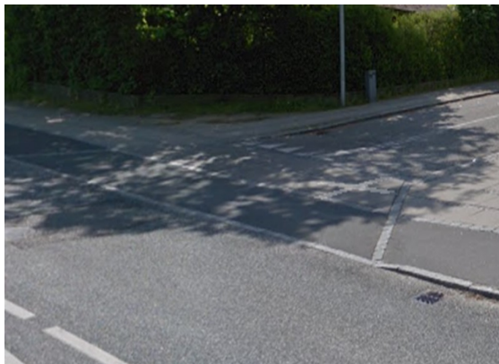
Frederiksborgvej/Prøvestensvej - Overkørsel med gennemgående flisefortov og cykelsti. Kantsten er sænket mod kørebanen.
