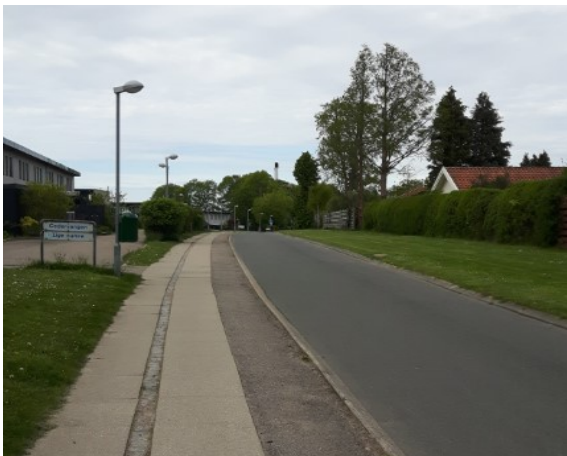
Fortov og cykelsti gennem Rønneholtparken
