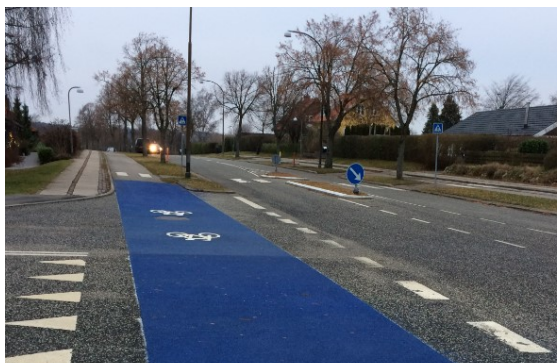
Bløvsstrød Alle - Nymarkeret cykelbane ved Sjælsø Alle.
