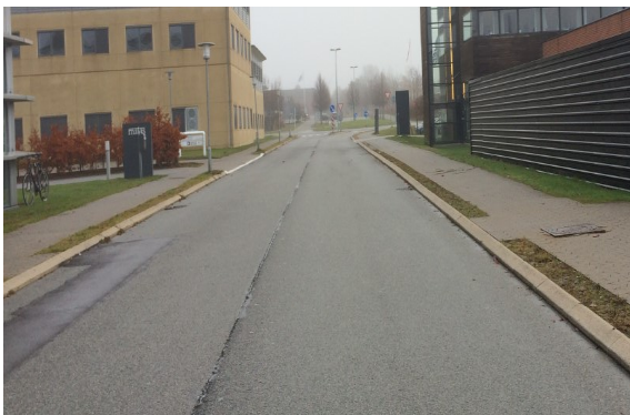
Rørmosevej - Fortove med SF-sten og betonkantsten
