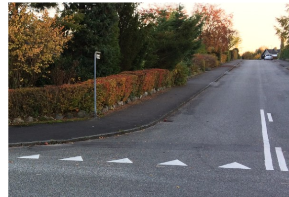
Asfaltfortov med kantsten i granit - Blovstrød
