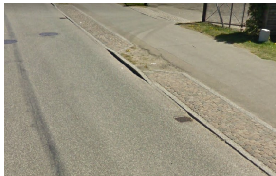
Nordkranvej - Overkørsel med brosten mod vej, mens fællestien er gennemgående.
