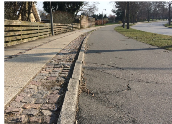
Sjælsø Alle, fortov med betonkantsten mod cykelsti
