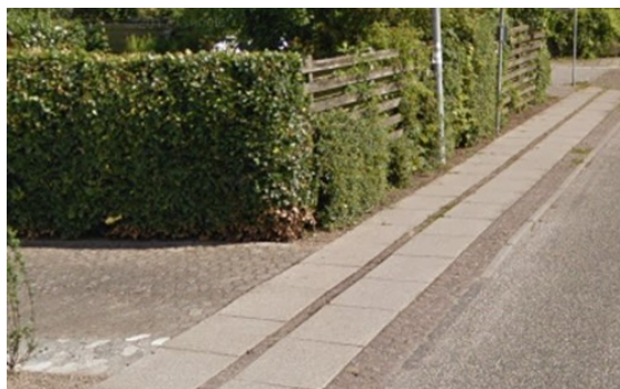
Boligvej - Overkørsel til ejendom med sænket kantsten og gennemgående fortov.
