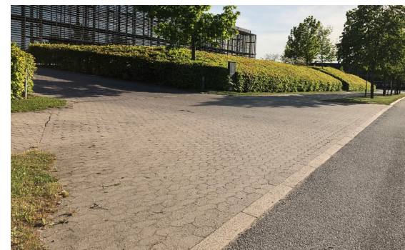
Bjarkesvej - Overkørsel, fortov og cykelsti i SF-sten.
